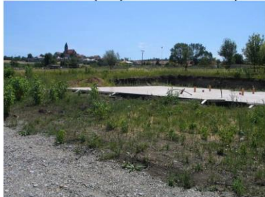
Foto 13: Pohled na plochy Z07 a Z08 s rozestavěnými stavbami.
